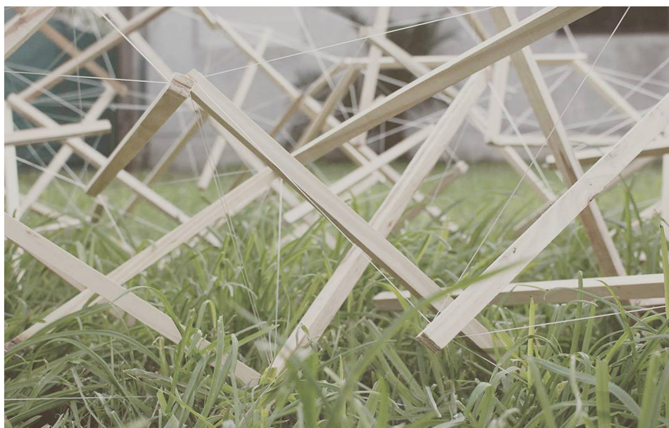
Tensegrity madera comprimida tanza traccionada, generando un equilibrio de esfuerzos y mazo
